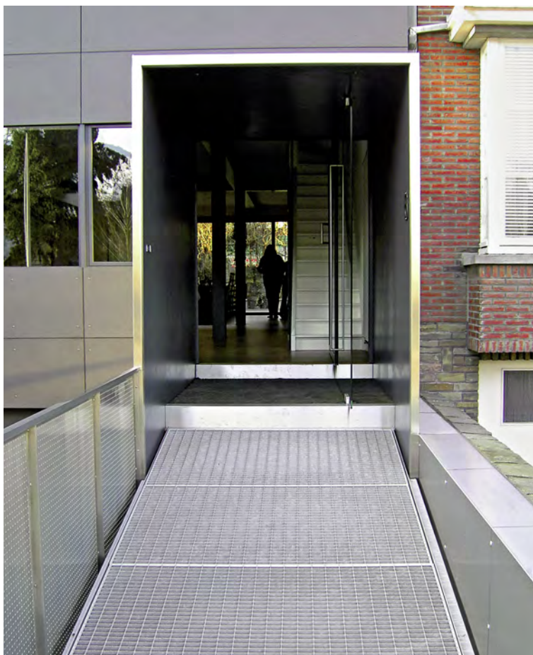
Galvanoitu metalliristikkoramppi tasaa katutason ja etuoven välisen korkeuseron.
